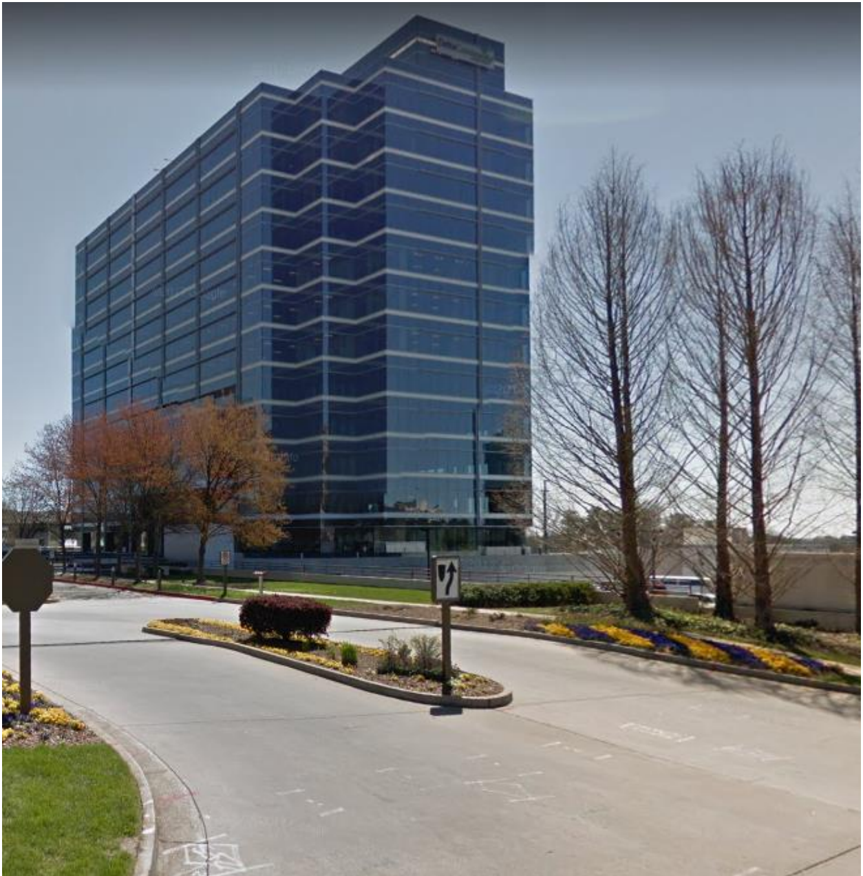
DCCU from Riverwood Pkwy.
